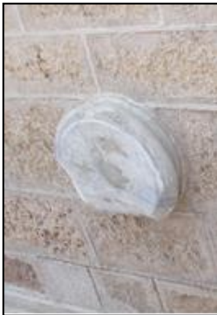
عمود رخامي كدعامة في جدار جامع السيد هاشم بحي الدرج
