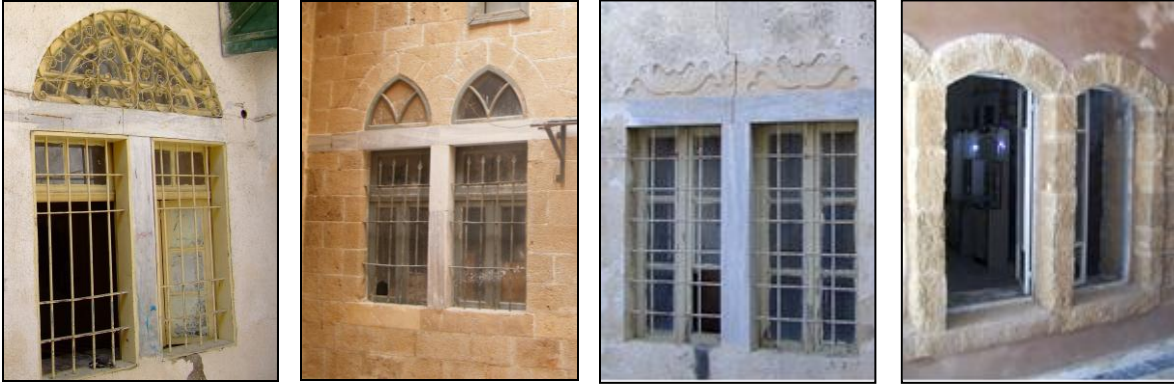
شبابيك تنتهي بعقد دائري في بيت آل أبو رمضان بحي الدرج شبابيك تنتهي بعقد خموس في بيت آل القرم بحي الدرج شبابيك تنتهي بعقد مستقيم في بيت آل الداية بحي الزيتون شبابيك تنتهي بعقد مبتور في بيت آل القيشاوي بحي الزيتون
